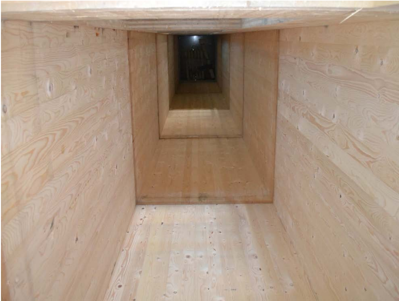
Cage d'ascenseur en CLT
