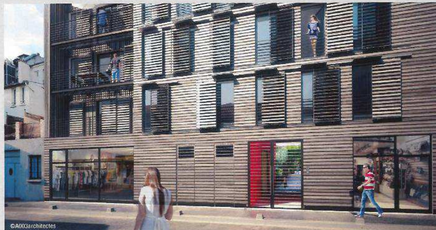
Construction passive tout bois sur 6 niveaux Rue Girard - Montreuil (93)
