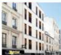
4 logements sociaux en béton de chanvre Paris
